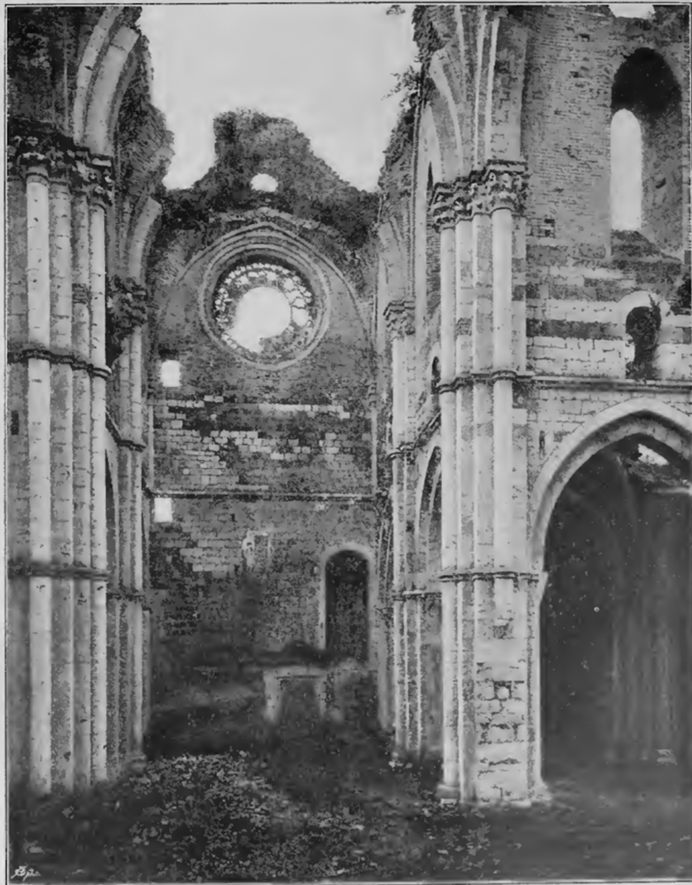
LATO SUD DEL TRANSEPTO DELLA CHIESA (INTERNO).
