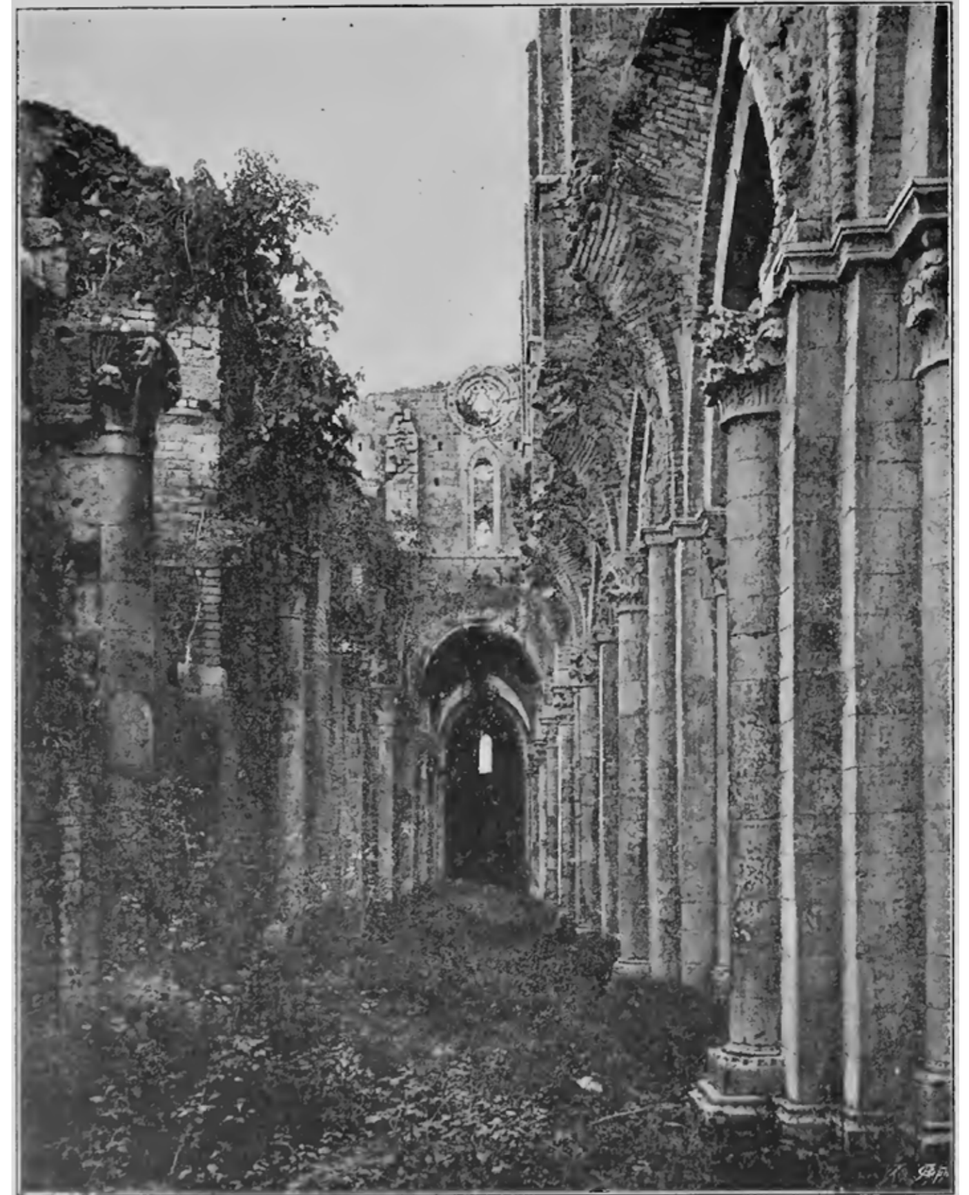
NAVATA NORD DELLA CHIESA VEDUTA VERSO IL TRANSEPTO.
