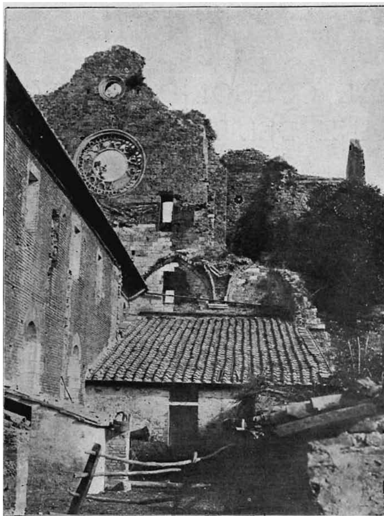
Tempio di S. Galgano - Testata sud del transetto.
