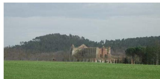
Fig. 4 – Veduta dal vecchio cimitero.
