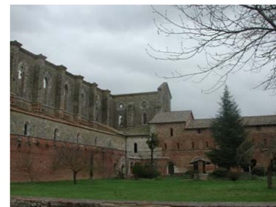
Fig. 6 – Veduta del Monastero e del chiostro originario.
